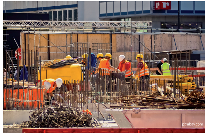
Hochbauarbeiter Beton- und Stahlbetonarbeiten
